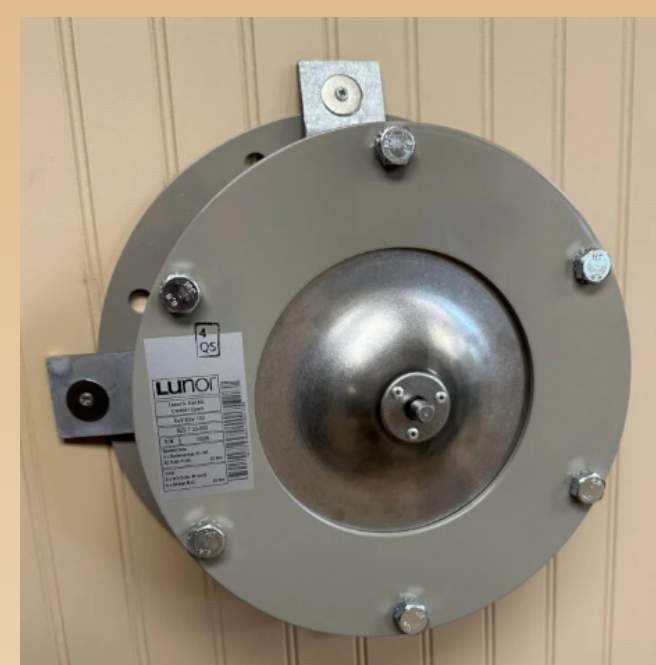
Valvola di sovrappressione AndAir che puo' essere chiusa manualmente
